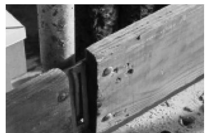
■ Защитные бортики, плотно прилегающие к краям платформ, обеспечивают защиту рабочих и прохожих. Когда эти бортики установлены, возможность подъема платформ исключена.
