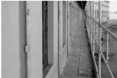
■ Перила расположены на одной линии с вертикальными частями рам лесов, что обеспечивает максимум рабочего пространства, свободного от каких-либо выступов. Полная ширина платформ – 0.75м, что является оптимальным для решения строительных задач.
